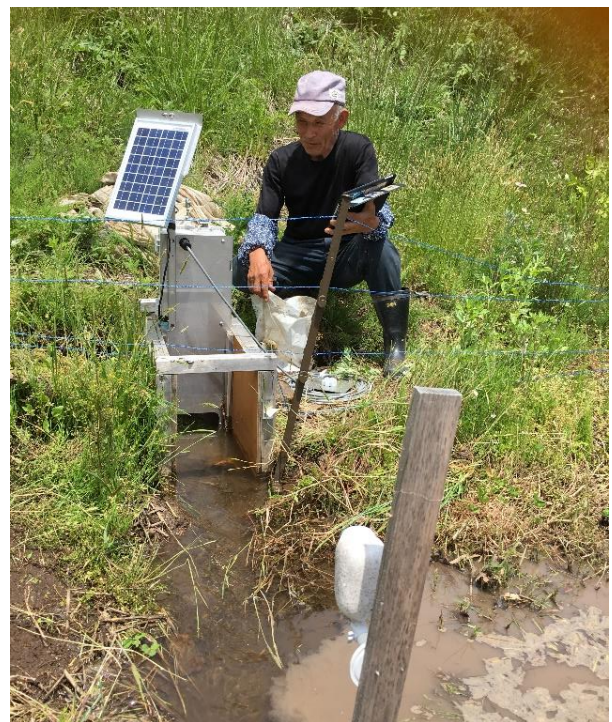
遠隔操作で水管理するための自動水門
